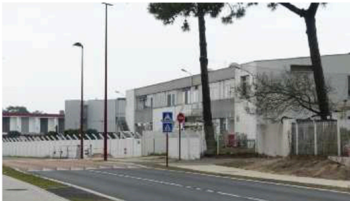
L'actuel restaurant de l'entreprise Safran. Début des travaux du nouveau restaurant interentreprises en 2023. J.-Y.L.
